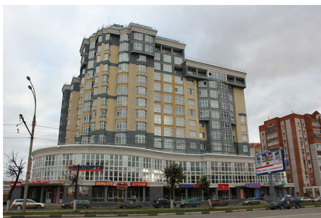
г. Иваново, компания-установщик «Техноальянс»
