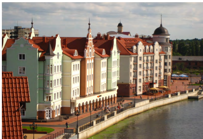
г. Калининград, «Рыбная деревня», компания-установщик «ПластикатСервис»
