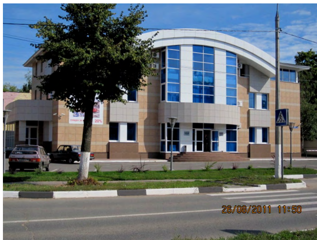
г. Луховицы, компания-установщик «STUDIO-DOM»
